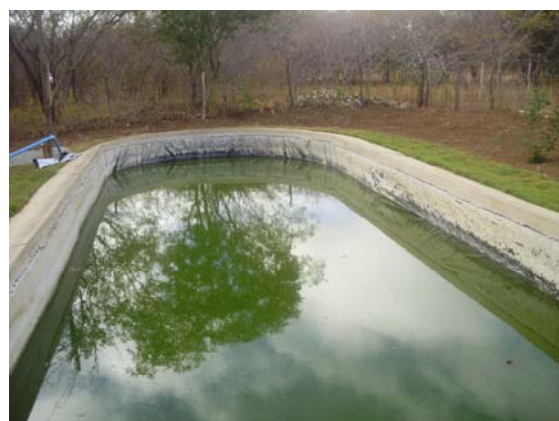
Figura 13: Local de onde foi furtada a bomba centrífuga.
