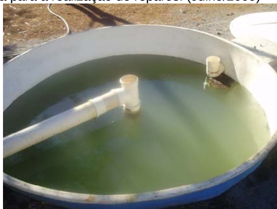
Figura 12: Tubulação reparada
