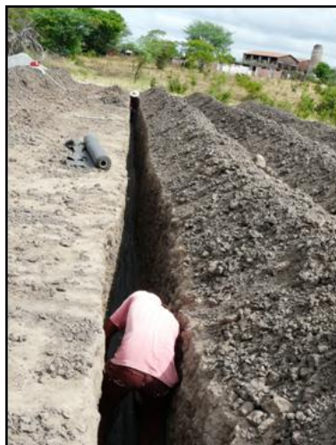
Figura 28 – Assentamento da manta geotêxtil.
