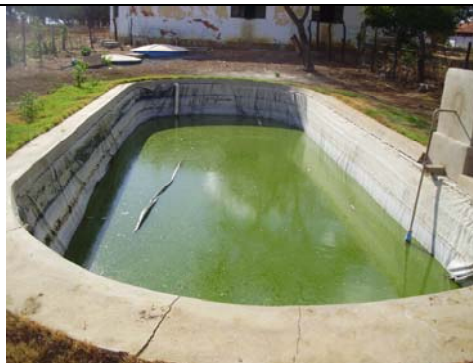
Figura 16: Lagoa esvaziada para reparo – sistema parado.
