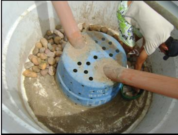
Figura 18 - Enchimento do filtro anaeróbio com seixos.
