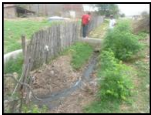
Figura 7 - Barragem de nível, observando-se um dos pontos de lançamento do esgoto da cidade, o qual foi escolhido para ser captado e tratado.
