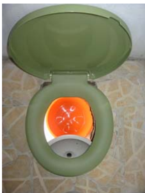
Figura 7: Vaso sanitário com separador de urina – primeira versão.
