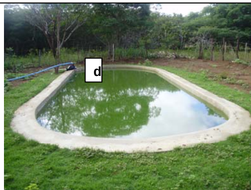
Figura 4: Lagoa facultativa e moto-bomba para irrigação (d).
