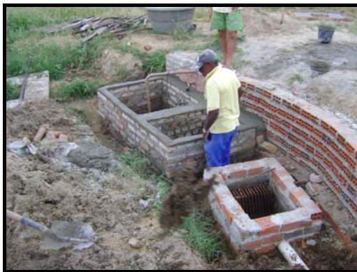
Figura 11 – Estrutura de pré-tratamento.
