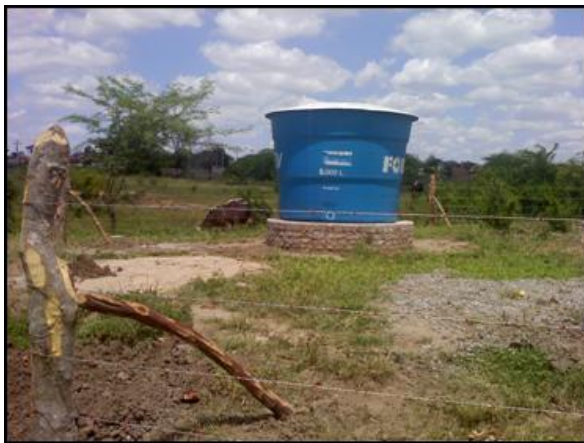
Figura 24 – Tanque de armazenamento do efluente utilizado na irrigação.
