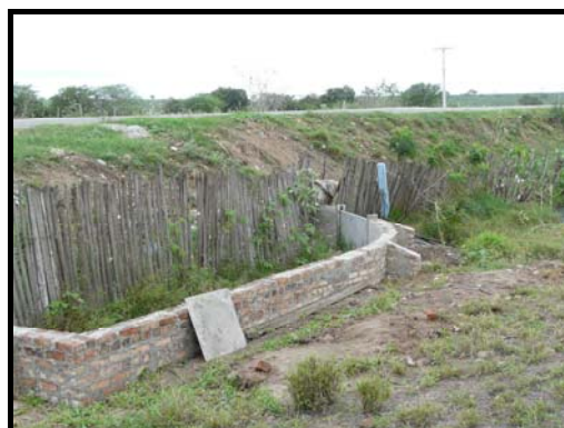
Figura 8- Barragem de nível, observando-se a estrada 416 em um nível mais alto.
