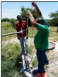
Figura 13 – Instalação da bomba submersa.
