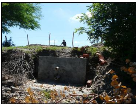
Figura 32 – Ponto de coleta dos drenos.
